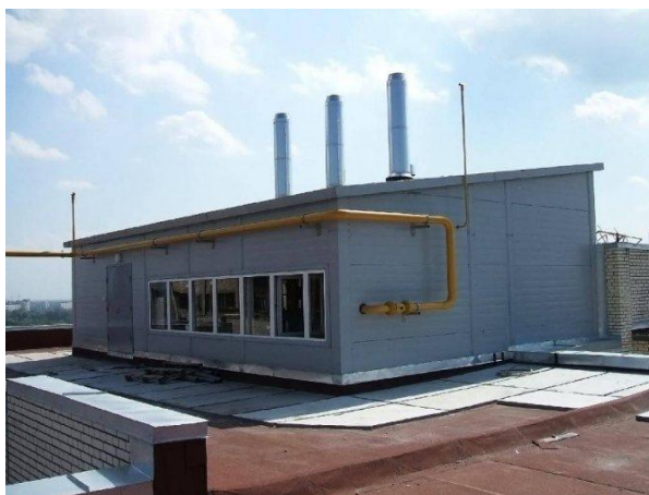
Рисунок 2 – Крышная котельная
